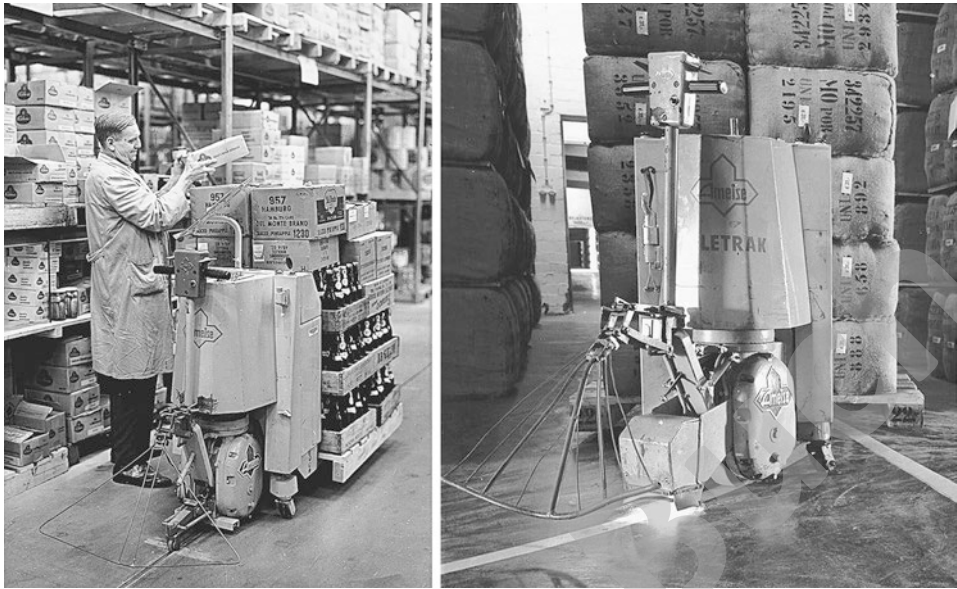
Abb. 1.3 Ameise/Teletrak. (Quelle: E&K 1965)
